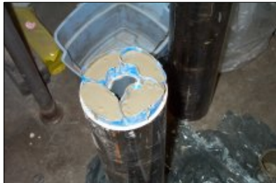
Step 5: Pour expanding concrete
